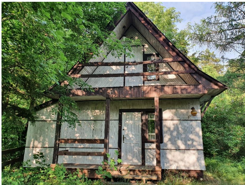
Zdjęcie 3: Widok budynku letniskowego nr 3
