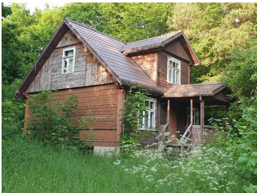
Zdjęcie 4: Widok budynku letniskowego nr 4
